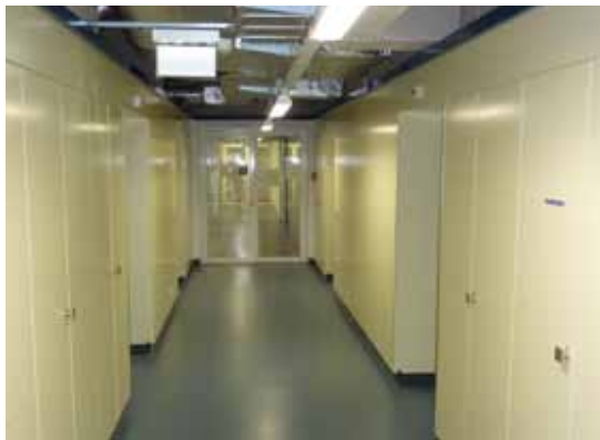
Image (5a, 5b): Laboratoire de Dübendorf rénové sur les plans énergétique et technique.
